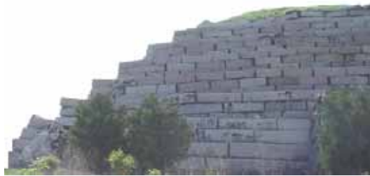
图 2 将军坟西北侧面沉陷倾斜、追踪张裂图
