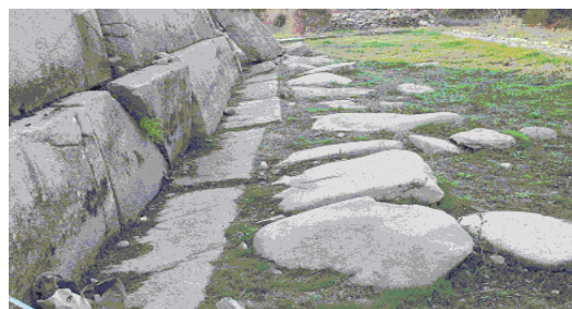
图 3 将军坟东北侧面护基石隆起图
