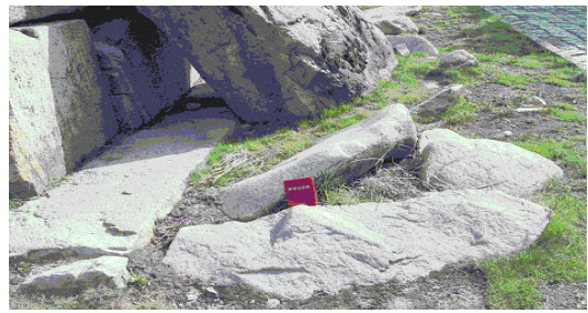
图 4 将军坟西北侧面护基石隆起图
