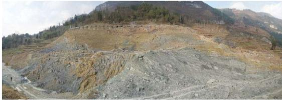
图3 边坡前缘变形破坏
