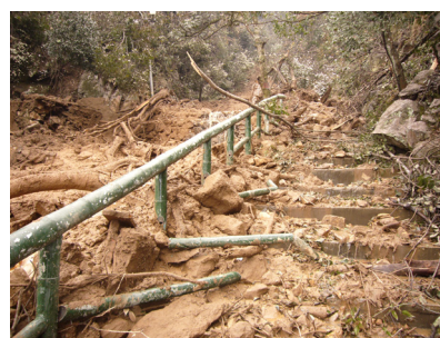
图 4 松散堆积体发生滑动
