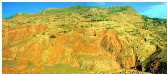
图1 八大山滑坡群全貌
